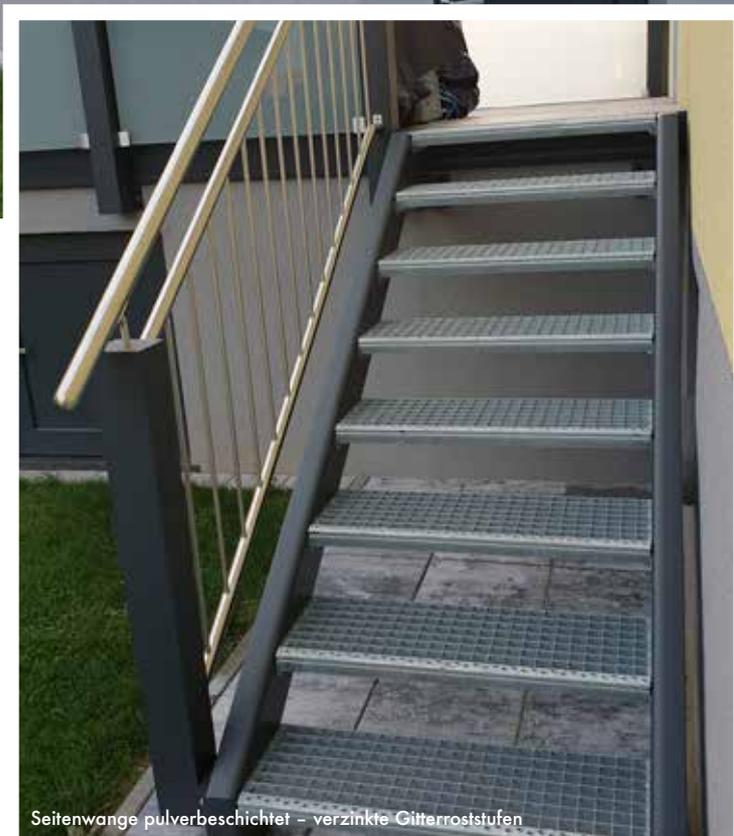
Seitenwange pulverbeschichtet - verzinkte Gitterroststufen
