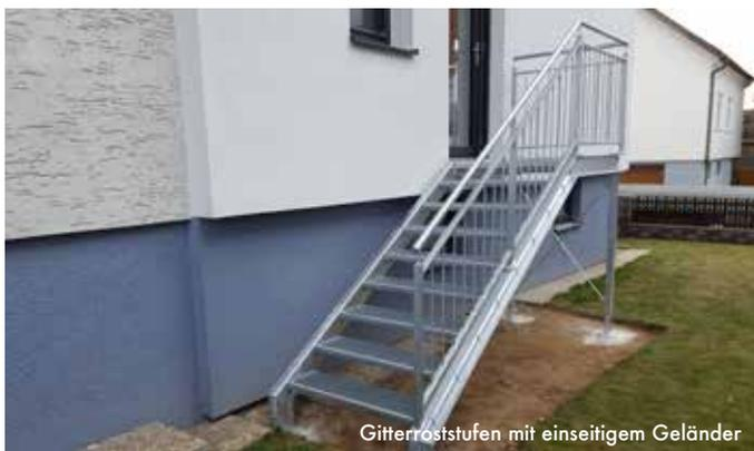
Gitterroststufen mit einseitigem Geländer
